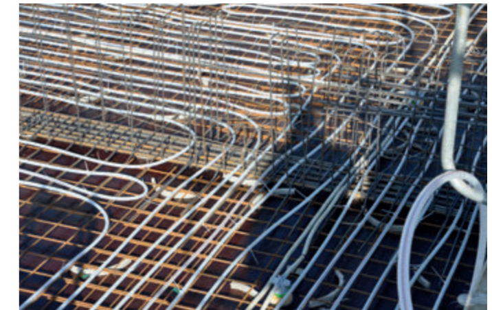
Betonkernaktivierung in der Decke, vor Einbringung des Betons.
