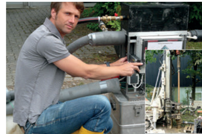
Markus Sommer, Sachverständiger für oberflächennahe Geothermie, bei der Testbohrung.
